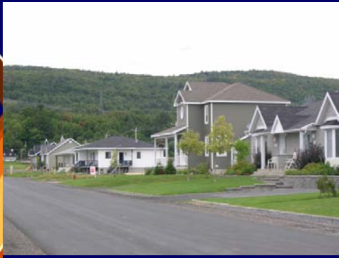
Nouvelles constructions sur la rue Huot
