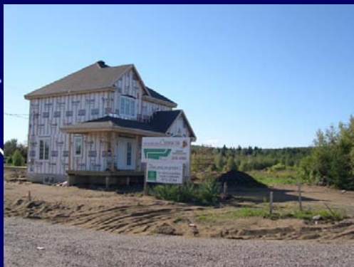
Maison en construction au Jardin des Cheminots
