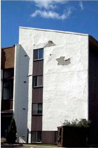
Figure 1. Usure d'un revêtement extérieur
